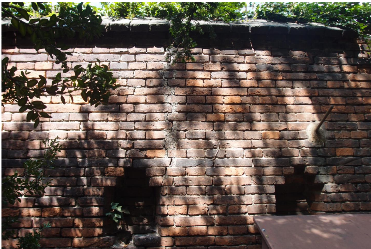
19. Úsek Z6-Z7 (střední část), vnitřní pohled, detail – trhlina ve zdivu
