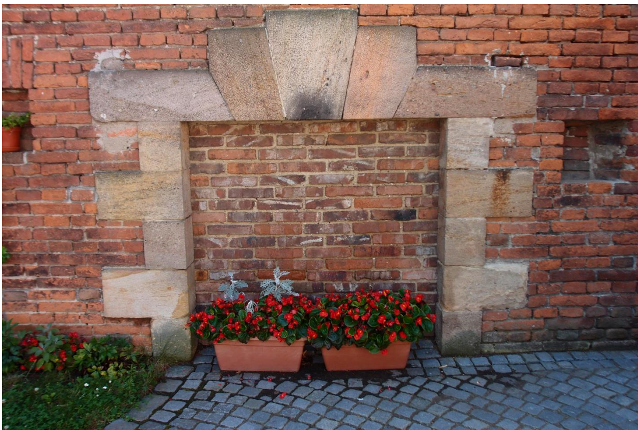
3. Úsek Z4-Z5, vnitřní pohled, detail – zazděná poterna
