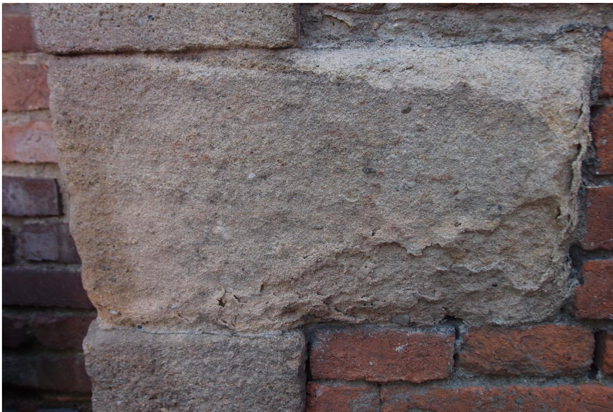
4. Úsek Z4-Z5, vnitřní pohled, detail – poškození kamenného ostění
