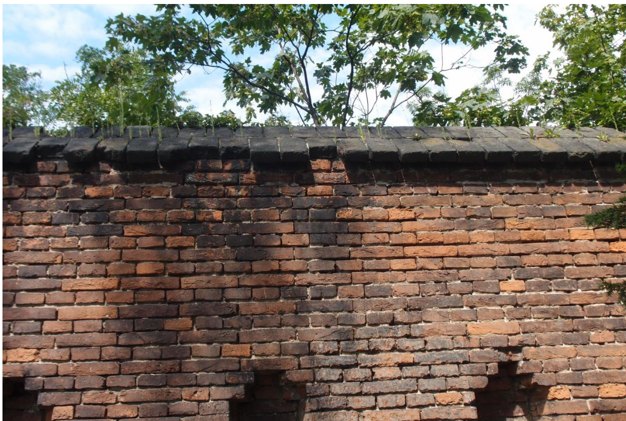
21. Úsek Z6-Z7 (jižní část), vnitřní pohled, detail – poškození koruny
