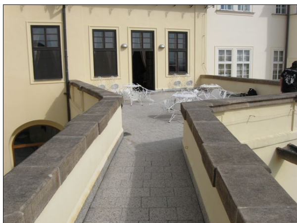
Foto /3/ Pohled na terasu – severovýchodní část
