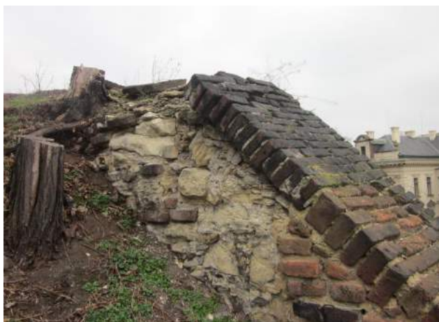
Koruna zdi 2B roh
