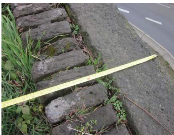
Detail koruny zdiva 2B
