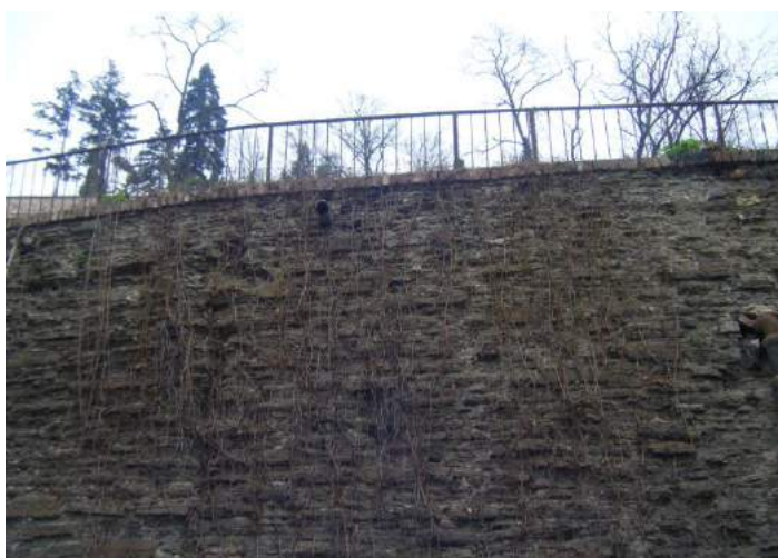
Pohled na korunu zdi 1 se zábradlím
