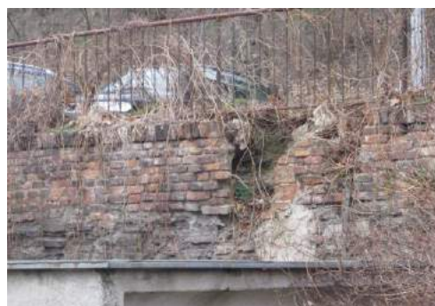
Zdivo nad garážemi zdi 1
