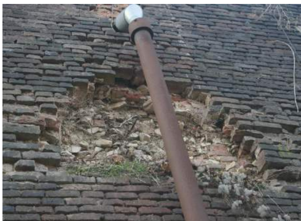
Kanalizační svod funkční na zdi 2B
