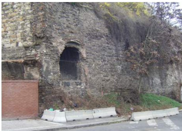
Pohled na západní konec zdi 1
