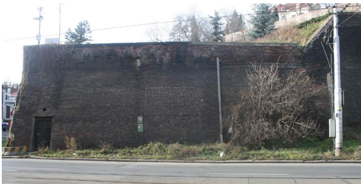
Pohled na levou část zdi 2B se vstupem
