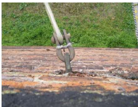
Kotvení tramvajové troleje zeď 2A
