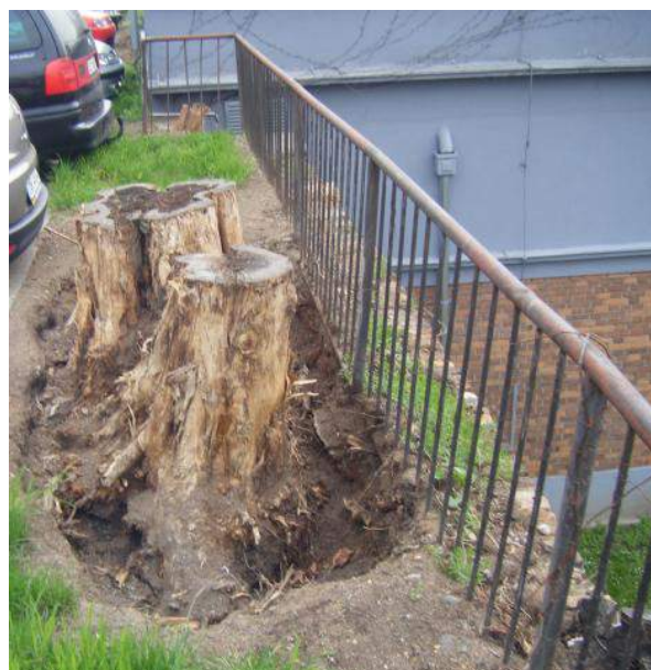
Koruna zdi 1 před trafostanicí
