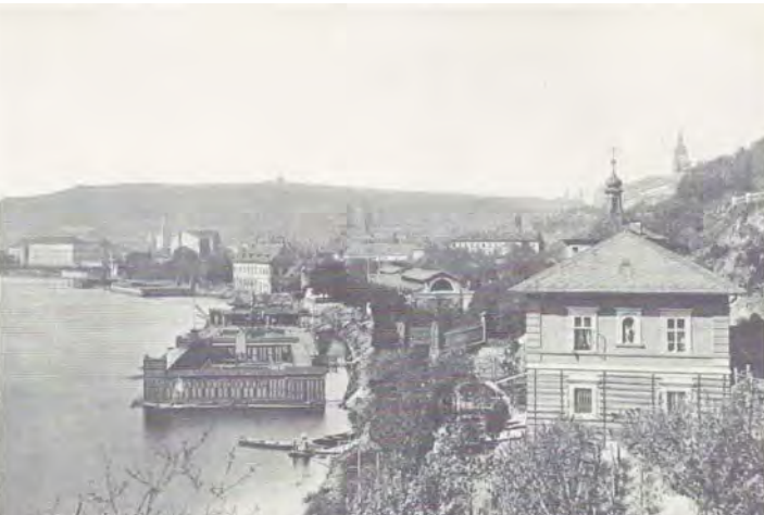
39. Vltavské plovárny u Jesuitské zahrady. (Fot. J. Eckert a J. Müllerem kolem 1870.) ■ V místech Jesuitské zahrady dnes Strakova akademie, stojí empriová stavba plovárny, pohled přibližně od dnešního Čechova mostu.
