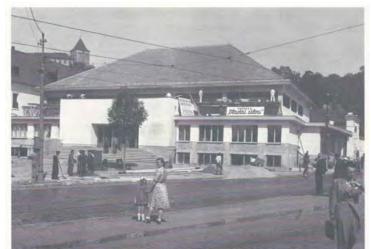
147. Výstavba pavilonu na Klárově. Budova postavená krátce po druhé světové válce na místě domu čp. 124-III (srovnej obr. 139) byla zbořena před stavbou stanice metra Malostranská v roce 1974. Foto kolem 1950.
