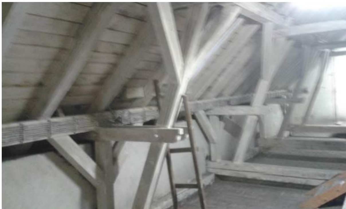
Obr. 16 – Vaznicová soustava se šikmými sloupky
