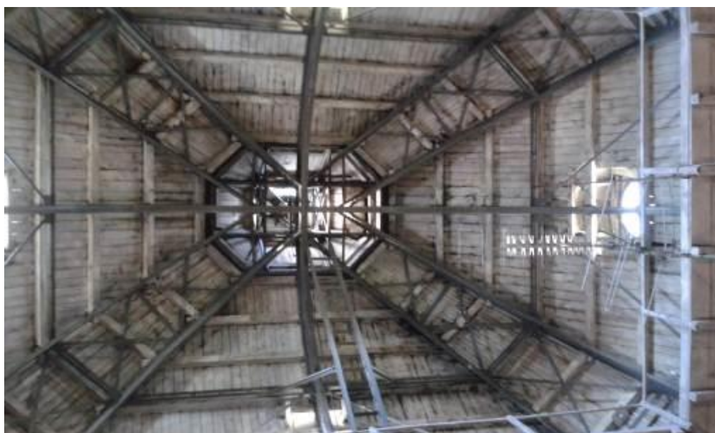
Obr. 15– Ocelová konstrukce kupole s valškými krokvi
