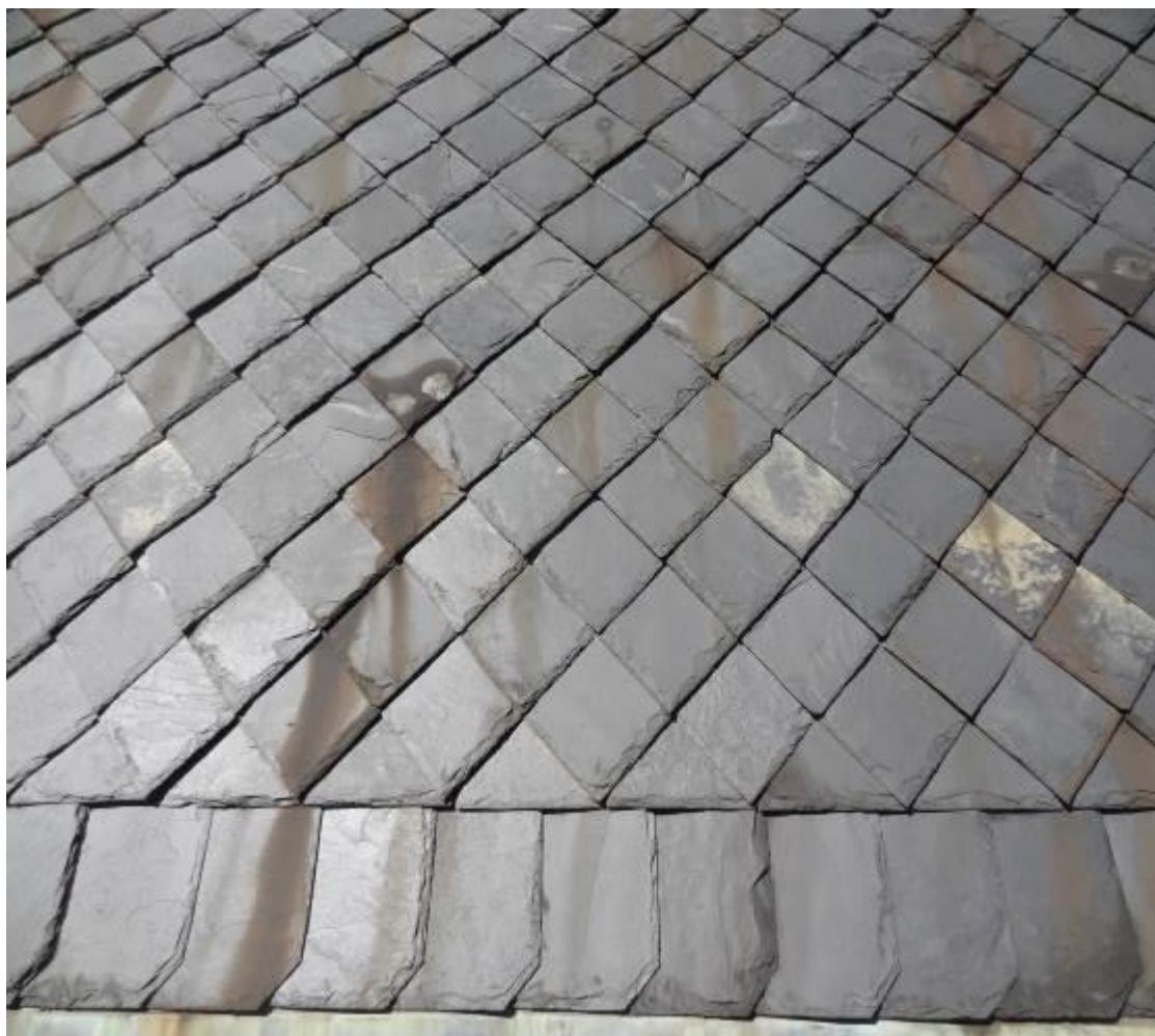
Obr.2 - Pohled na část plochy střechy.
