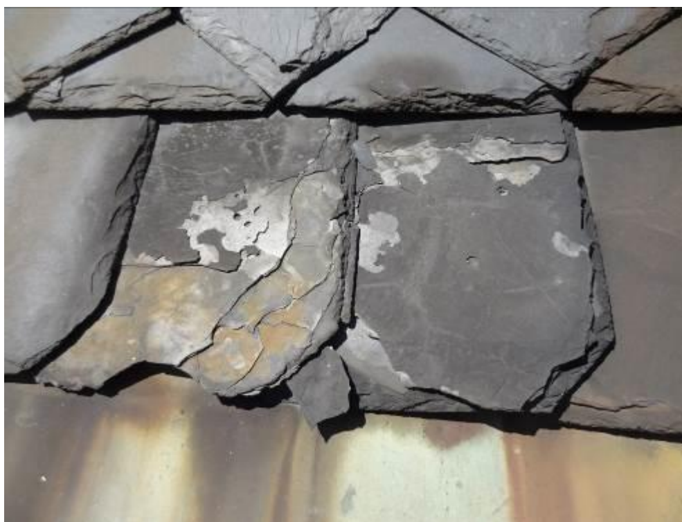
Obr. 11 – Zvětralé a rozpadlé okapové lemovky břidlice
