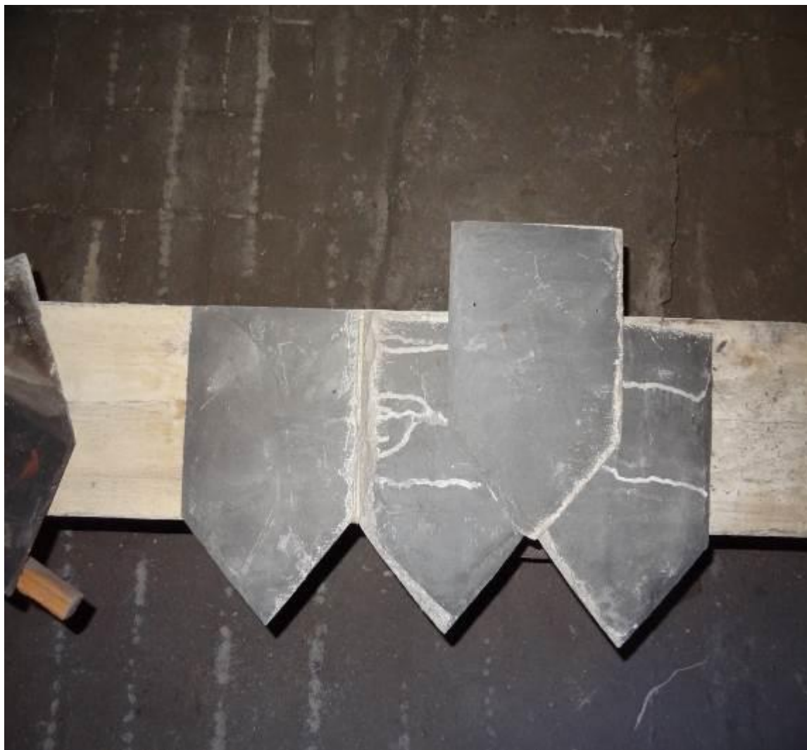
Obr. 3 – vzor tvaru střešní krytiny v ploše střechy
