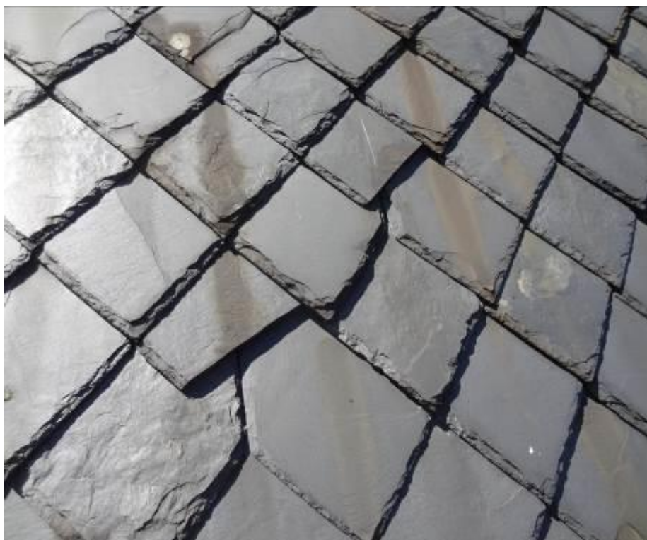
Obr. 8 – Poškozené kusy kamene – zdroj zatékání
