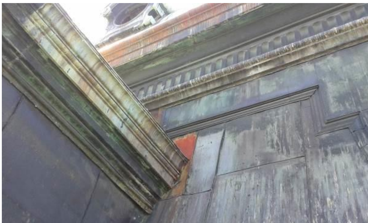
Obr. 19 – Prvky centrální bání s červeným nátěrem
