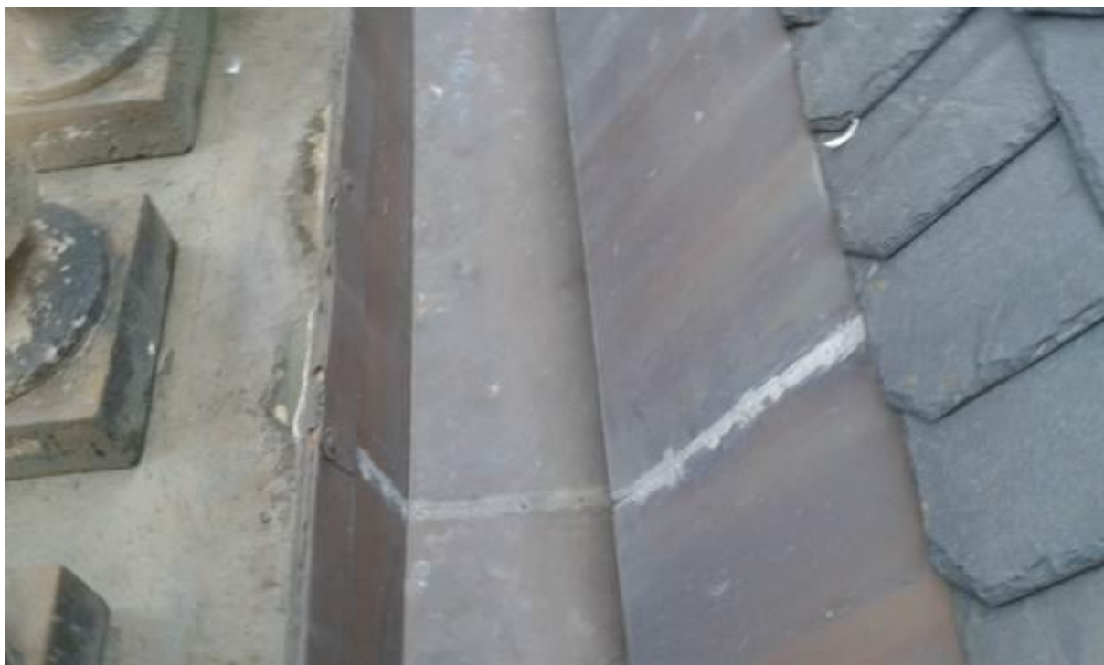
Obr. 25 – Dožilé tmelení u žlabu
