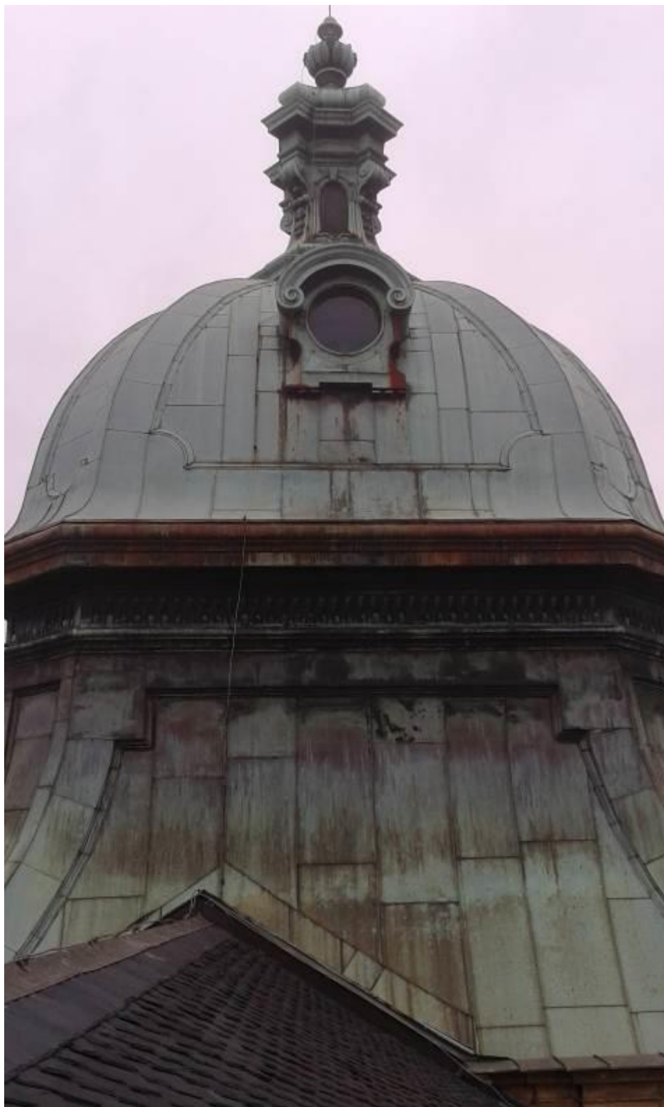
Obr. 20 – Prvky centrální bání s červeným nátěrem
