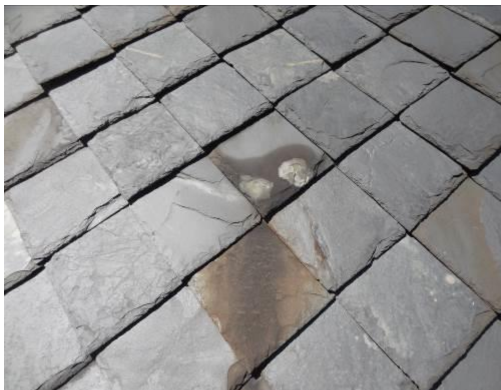
Obr. 5 – zvětralá a oxidující břidlice
