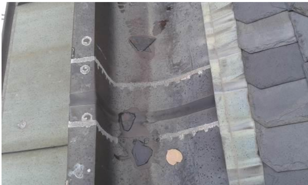
Obr. 28 – Pryžová dilatace ve žlabu
