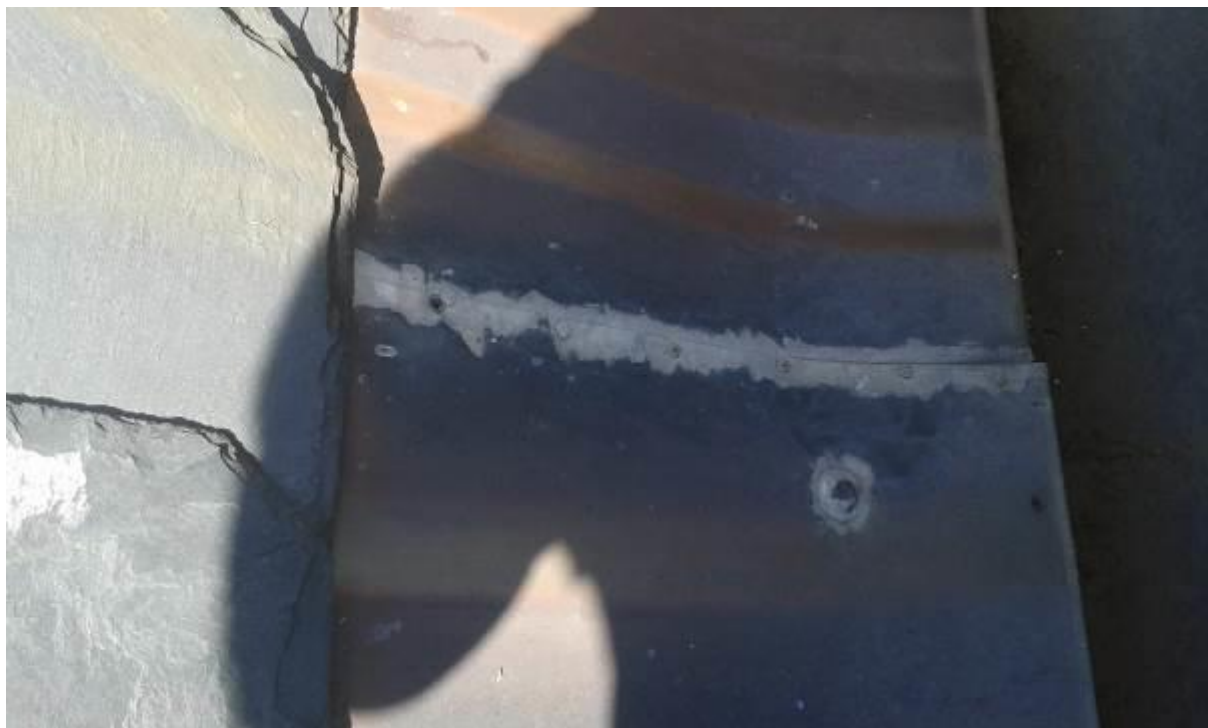
Obr. 23 - Hřebíky probítá žlabu místě spojky
