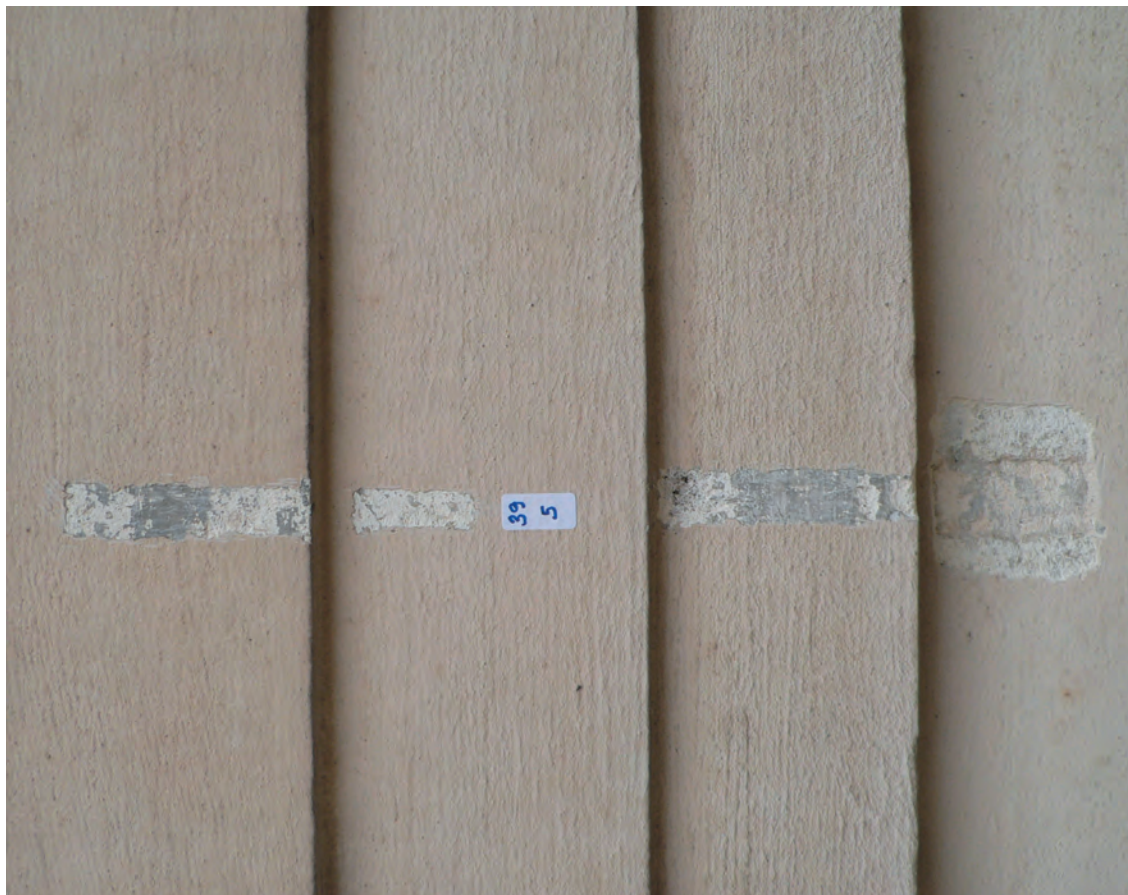
sonda 5 - zbytky nátěrů pod hlavní římsou
