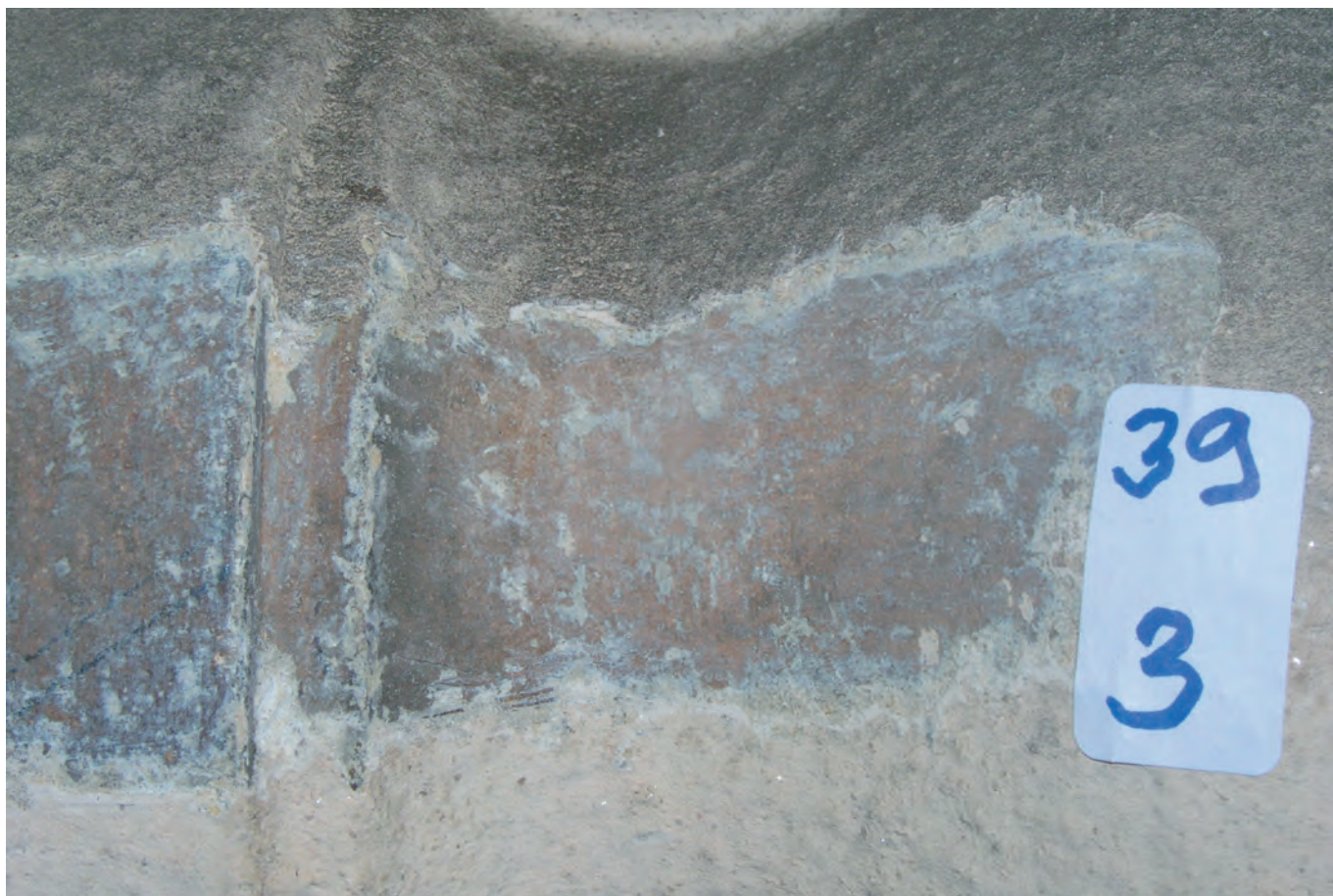
sonda 3 - starší rezný okrový vápenný nátěr
