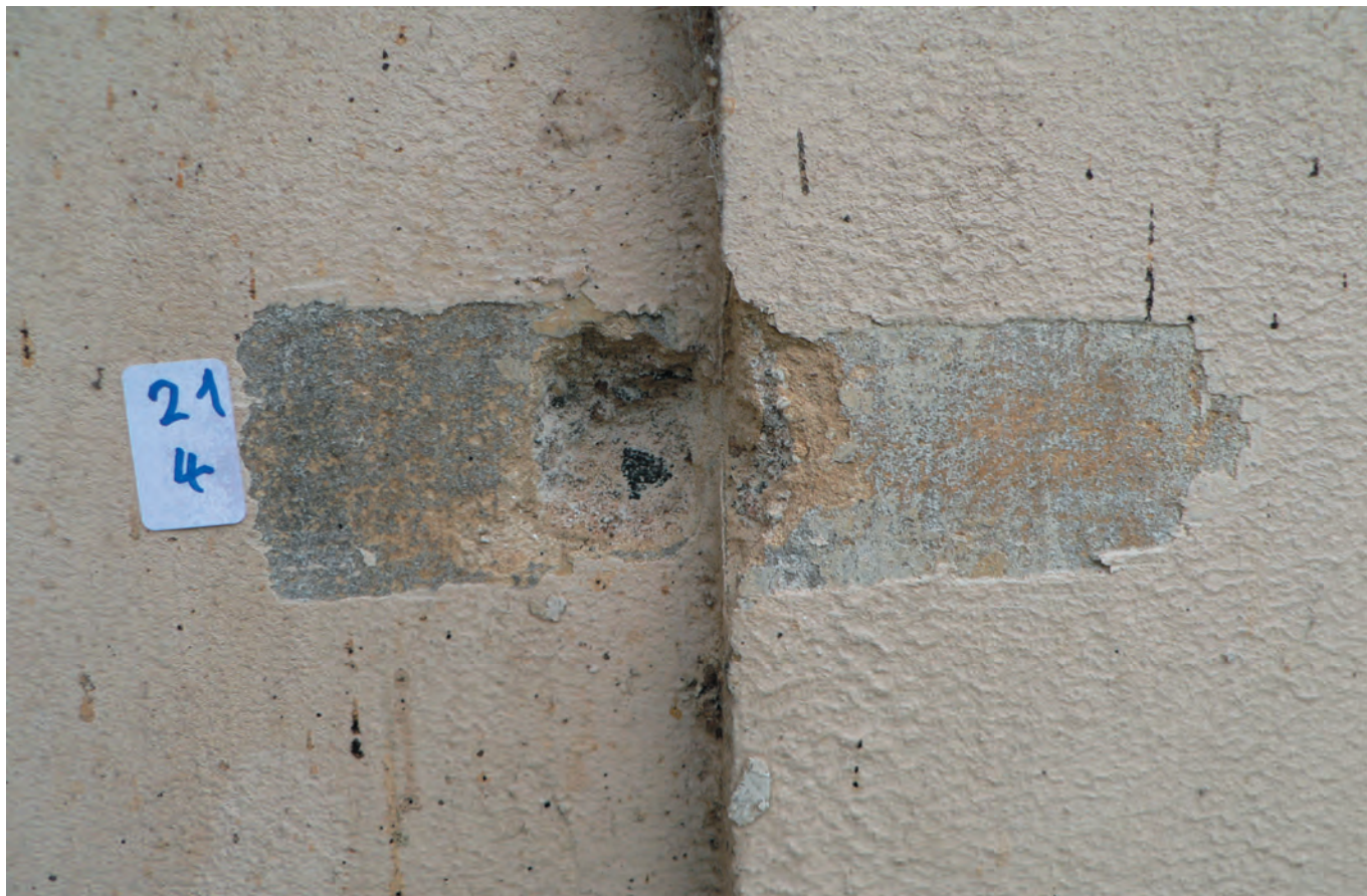
sonda 4 v ploše a na pilastru fasády 21
