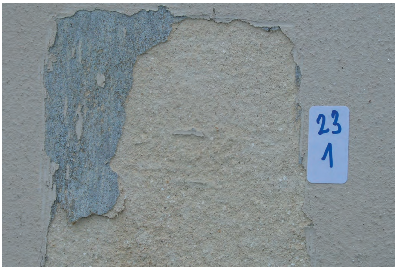
sonda 1 - stav omítkových vrstev na fasádě 23
