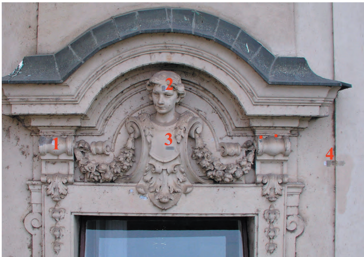
lokalizace sond na fasádě 21
