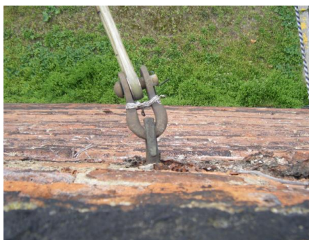
Kotvení tramvajové troleje zed' 2A
