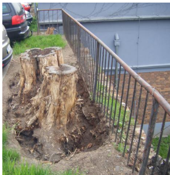
Koruna zdi 1 před trafostanicí
