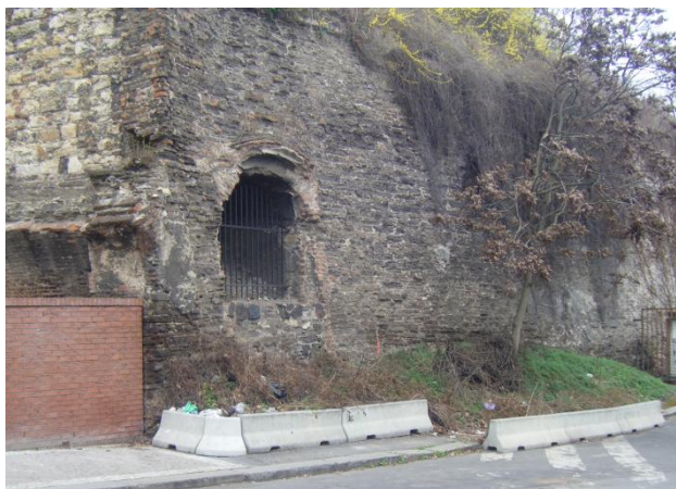
Pohled na západní konec zdi 1
