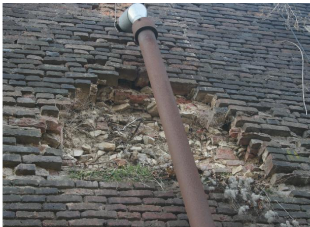
Kanalizační svod funkční na zdi 2B
