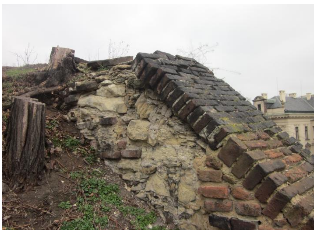
Koruna zdi 2B roh
