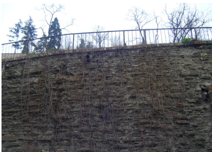
Pohled na korunu zdi 1 se zábradlím
