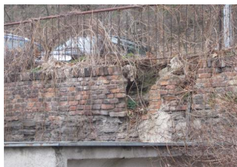
Zdivo nad garážemi zdi 1
