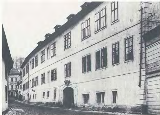
142. Kasárna v Brusce čp. 132-III. Velká budova se čtyřmi křídly a arkádovým nádvořím byla zbořena v roce 1928. Foto kolem 1910
