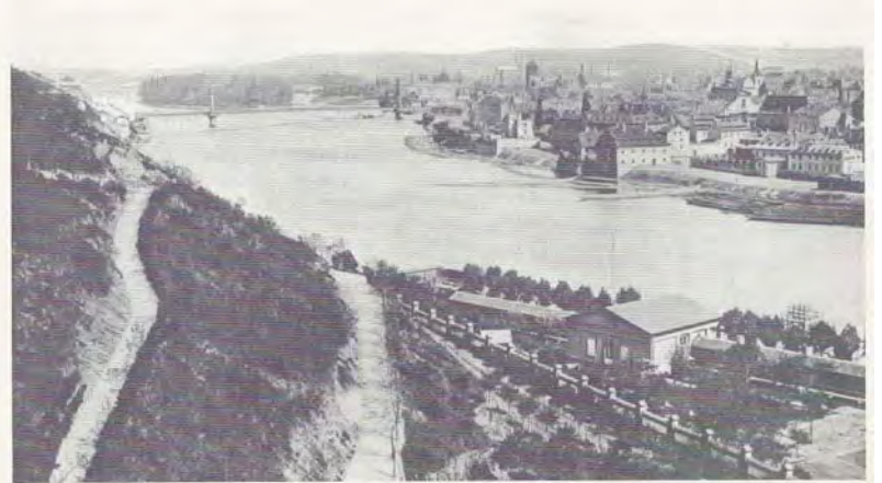
38. Pohled s Letné na vltavské pobřeží od Rejdiště ke Švánci. Vpředu Občanská plovárna a pěší cesta na Letné. (Fot. Fr. Frídřích 1869.) ■ Místo řetězového mostu v pozadí dnes Štefaníkův, podél břehu vede náhleží E. Beneše (a Kosárkovo), na Rejdišti stojí Rudolfínium.
