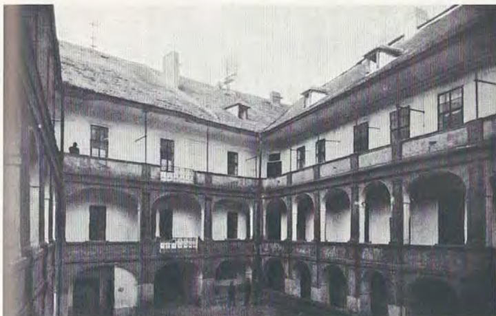
35. Nádvoří kasáren v Brusce, čp. 132, přestavěných 1779 z býv. domu Kriegelsteinského, zbořeno 1930. (Fot. amat. kolem 1920.) ■ přibližně v místech transformační stanice, nároží ulice Pod Bruskou
