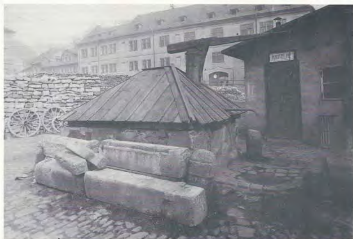
148. Starší studna v areálu vojenského skladiště na Klárově. V pozadí budova kasáren v Brusce čp. 132-III. Foto kolem 1920
