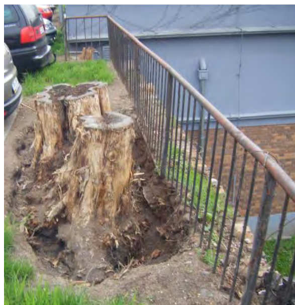
Koruna zdi 1 před trafostanicí
