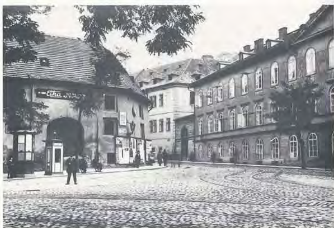
141. Královská vápenice čp. 149-III na Klárově. Budova někdejší cihelny a vápenice stála na nároží Valdštejnské ulice a Klárově (zbořena 1924). Foto kolem 1920
