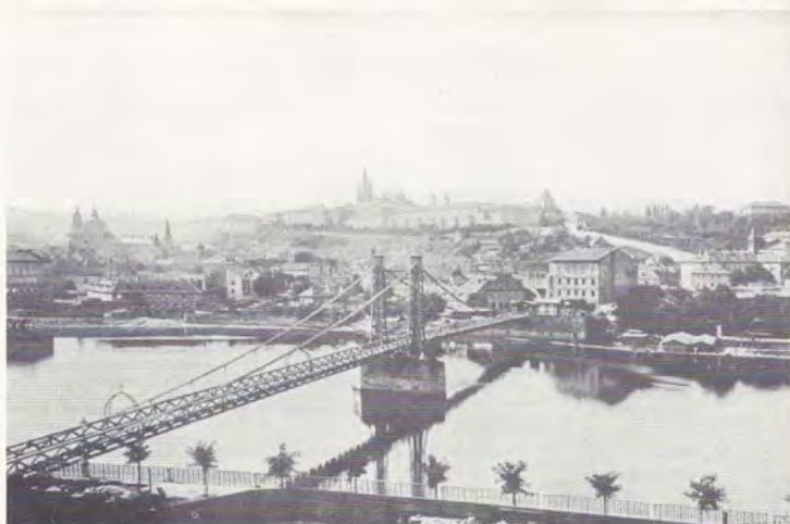
41. Železná lávka od nábreží Rudolfova na Klárově. (Fot. kolem 1880.) ■ Dnes o několik metrů vlevo Máněsův most, lávka zbořena
