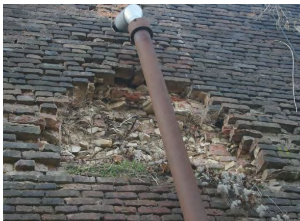
Kanalizační svod funkční na zdi 2B
