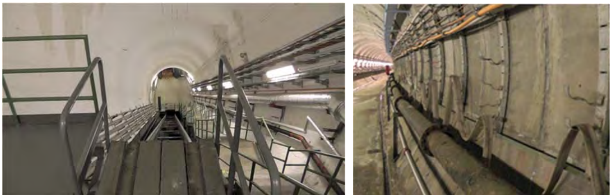
Vnitřní prostory bývalého krytu pod bastionem XIX opravdu připomínají soudobé konstrukce tunelů metra.
