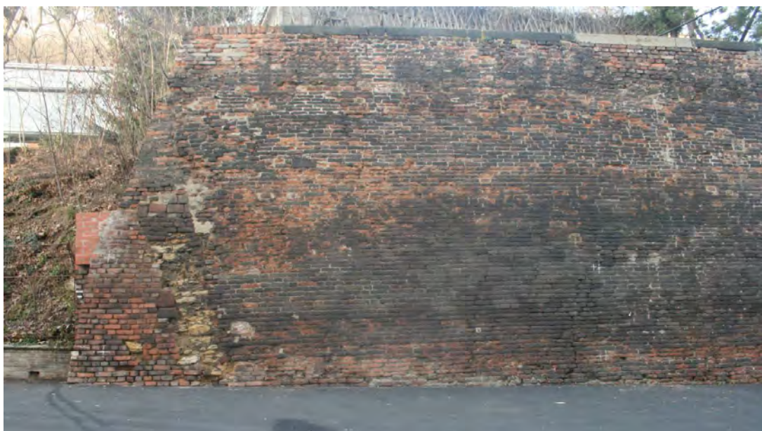
Pohled na levou část zdi 2A
