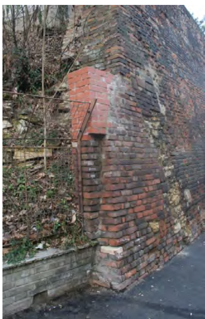
Roh ukončení zdi 2A
