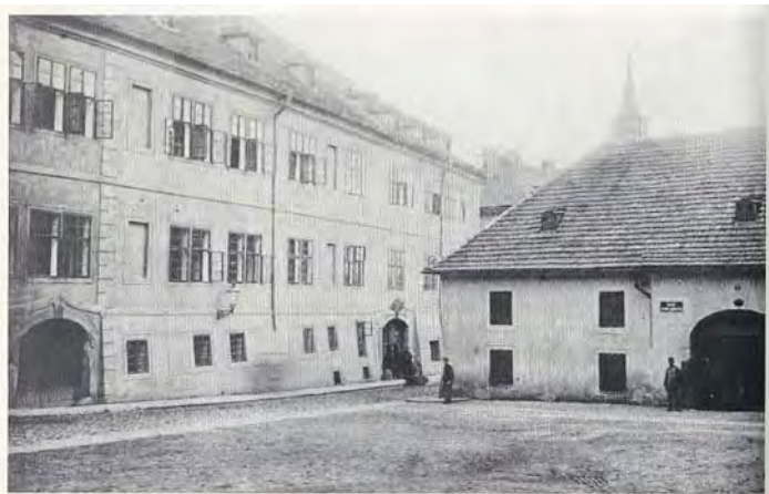
38. Kasárny v Brusce čp. 132. Přestavěny z domu Kriegelsteinského 1779, zbořeny 1930. Na jich místě transformační stanice elektr. drah a nová ulice k Strakově akademii. (Fot. amat. kolem 1915.) ■ přibližně v místech transformační stanice, nároží ulice Pod Bruskou
