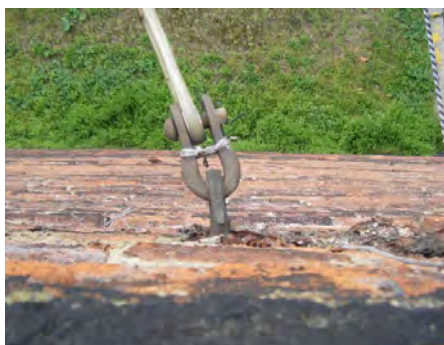
Kotvení tramvajové troleje zed' 2A
