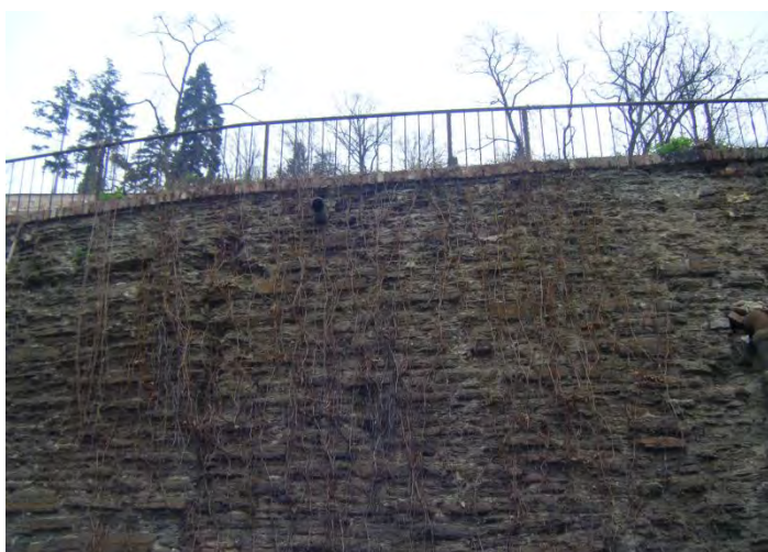
Pohled na korunu zdi 1 se zábradlím
